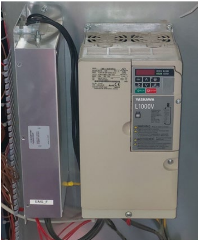
Частотный преобразователь YASKAWA L1000V для лифтов OTIS 2000R
