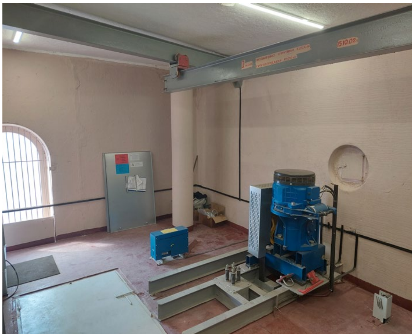
Электрические лебедки производства ОАО «Карачаровский механический завод», грузоподъемностью 400 и 630 кг
